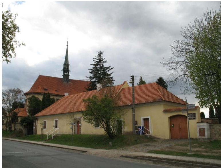
Obr. 7. Velvary, budova bývalého špitálu za Pražskou branou s kostelem sv. Jiří.
